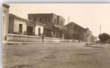
Figura 8- Aracati, rua Coronel Alexanzito- antigo prédio dos correios.
