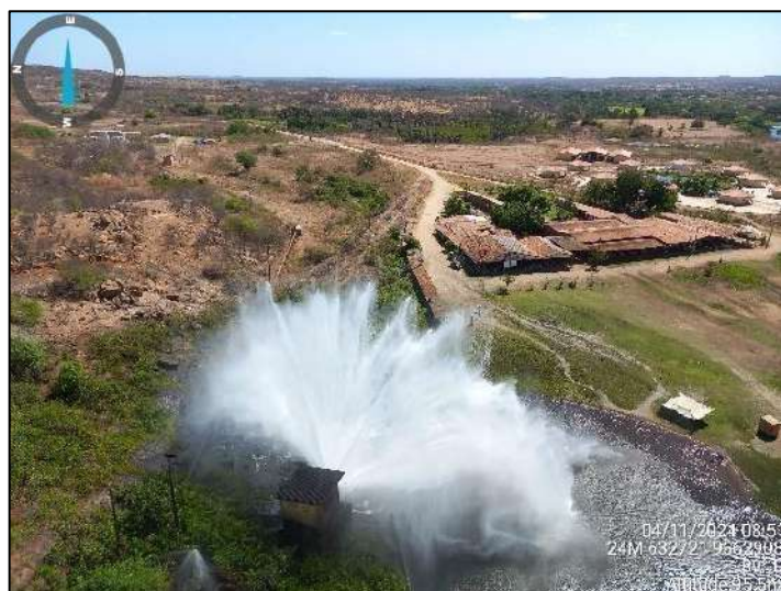
Figura 29- Barragem de Santa Cruz em Apodi/RN, com destaque para a válvula difusora, localizada após o ponto 22.
