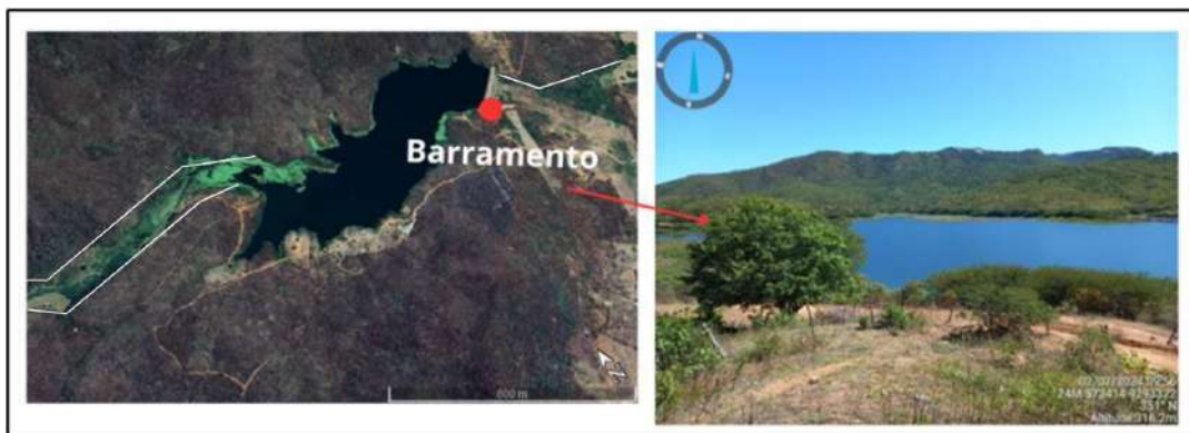
Figura 14 - Trecho 2-3 com presença de vale confinado e interferência de barramento.
