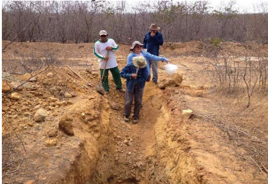
Figura 17: Abertura do perfil
