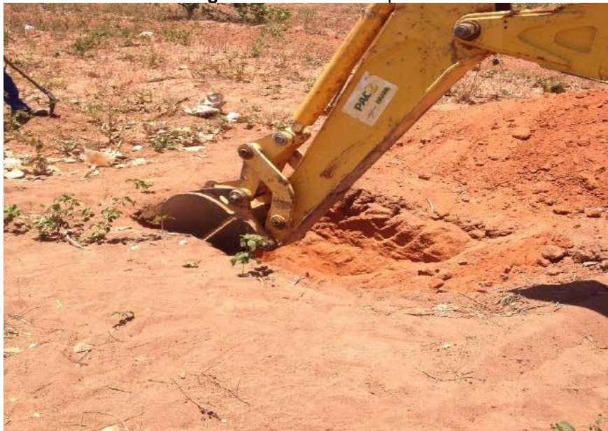
Figura 16: Abertura do perfil
