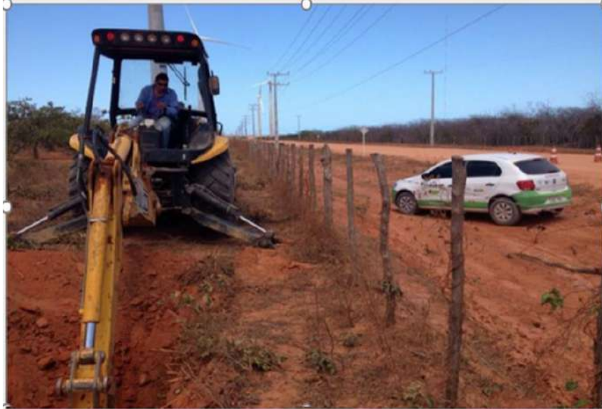
Figura 15: Abertura do perfil de solo
