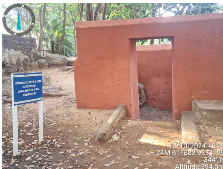
Figura 14 – Banheiro desativado no Complexo da Bica, Portalegre/RN
