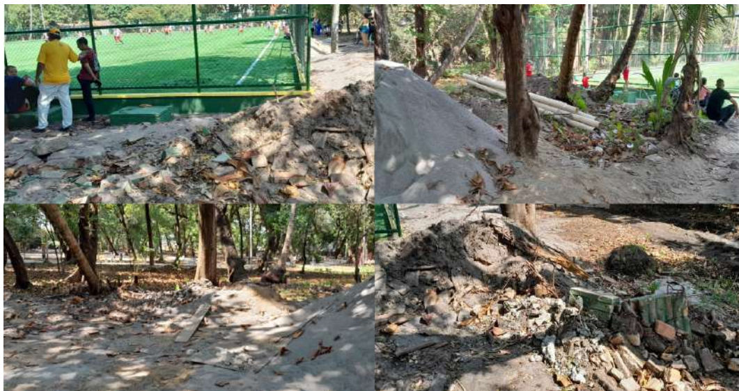
Figura 18 – Entulhos da obra de requalificação do Parque Urbano Rio Branco.
