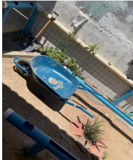
Figura 1 - Início da montagem do Jardim Sensorial com as bases em cano PVC já fixadas no ambiente para o plantio das mudas.
